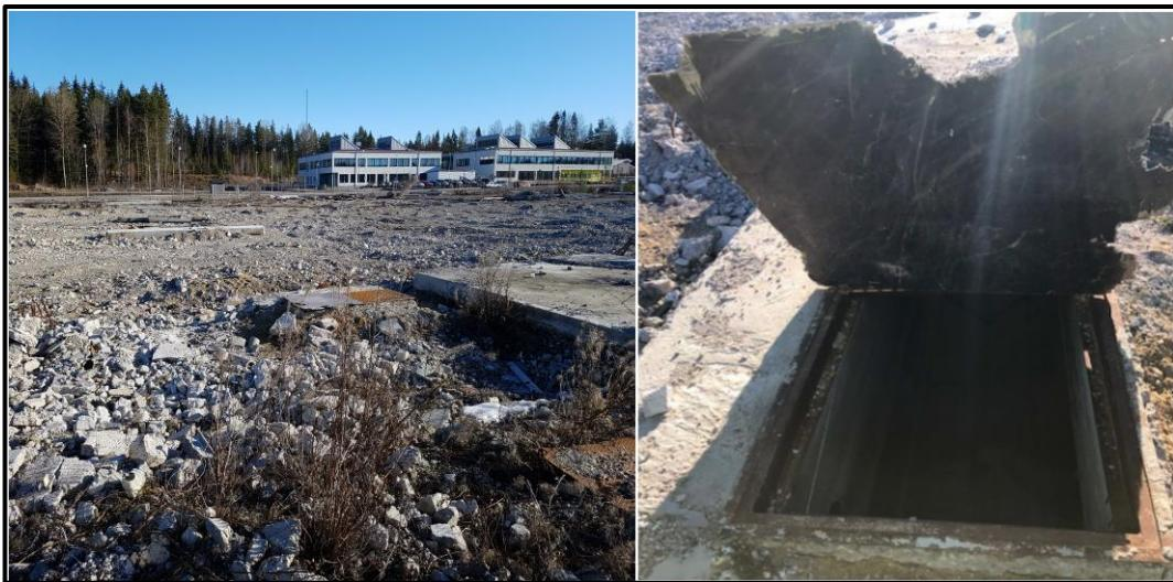
Figur 3 Källarutrymmen och hålrum som lämnats kvar från betongverksamheten [3].
