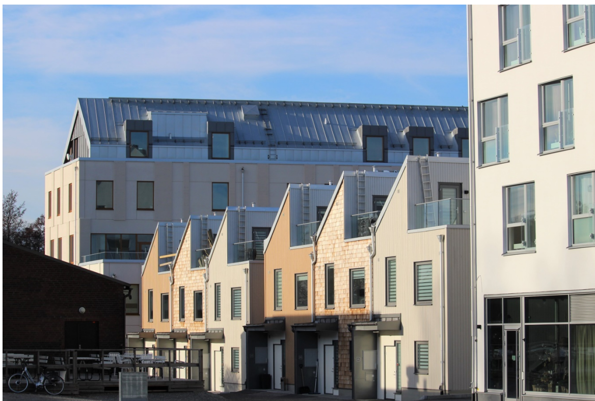
Figur 12. Nybyggnation i centrala Nykvarn. Foto: Nykarvns kommun
