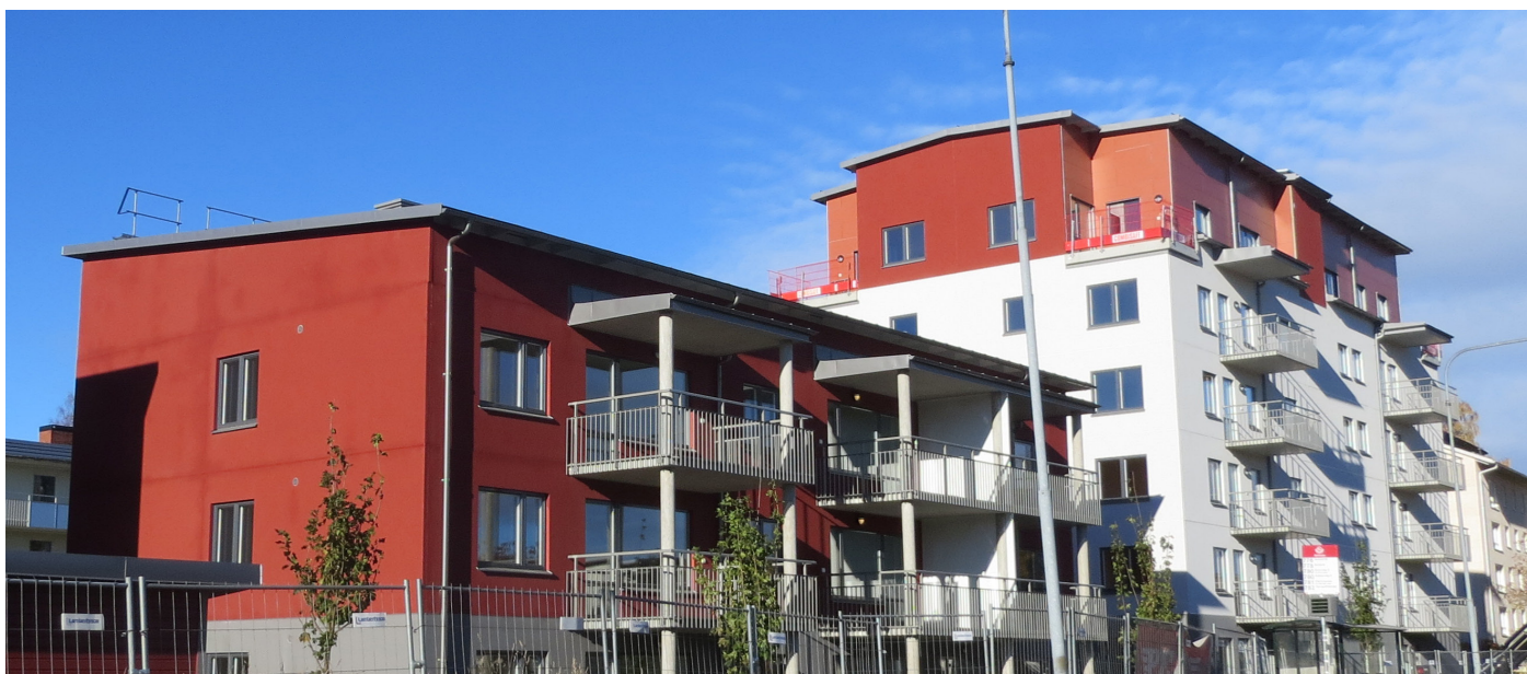
Bostäder under byggnation vid Järnavägen år 2015.
