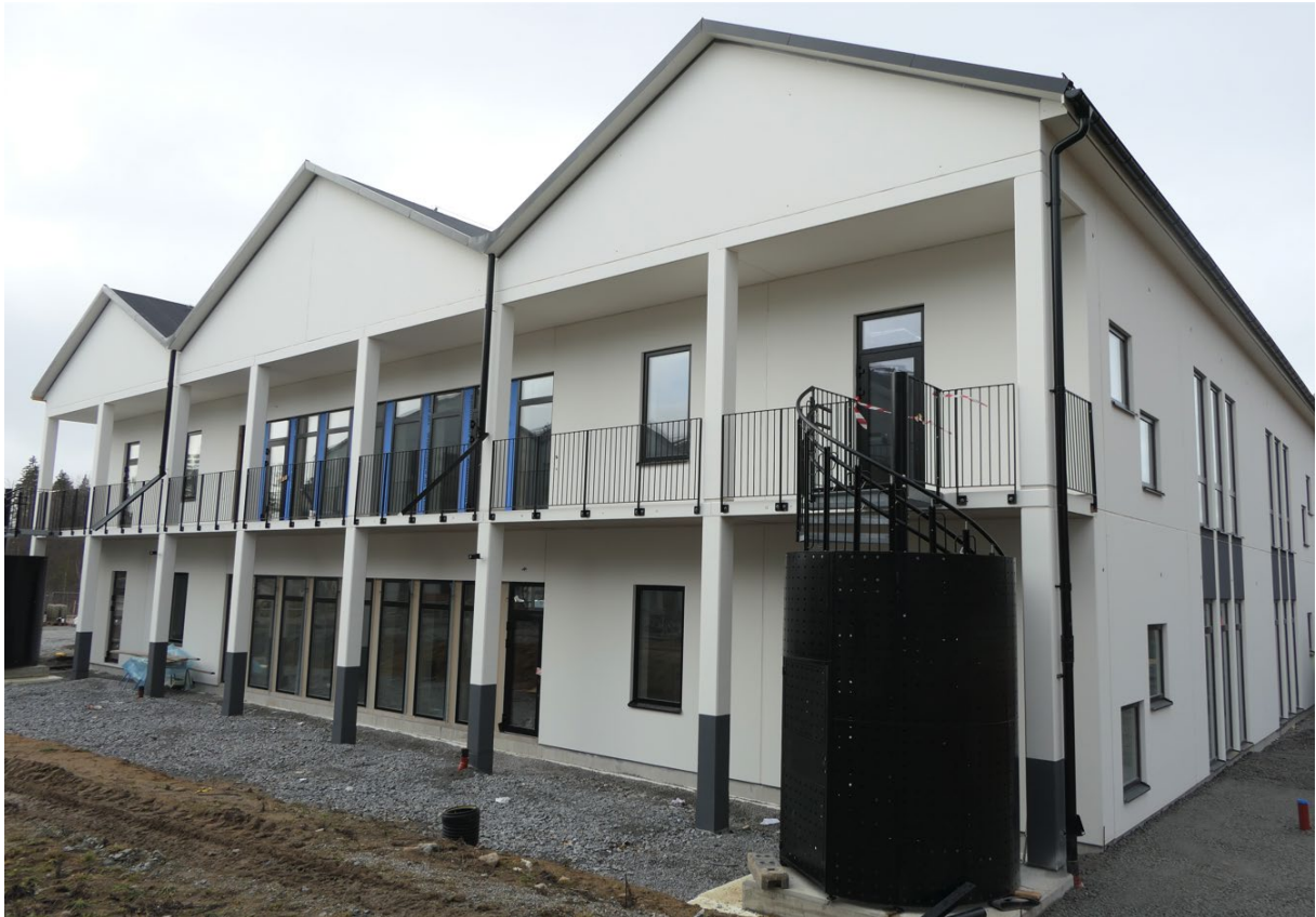
Bergtorpsförskola under byggnation.
